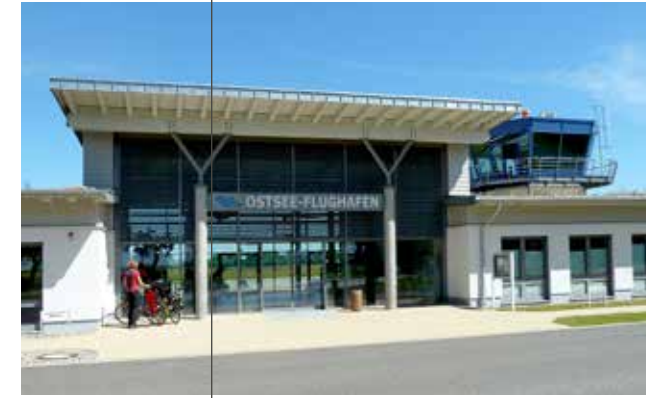
Eingang in das neue Terminal des Ostseeflughafens Stralsund-Barth
