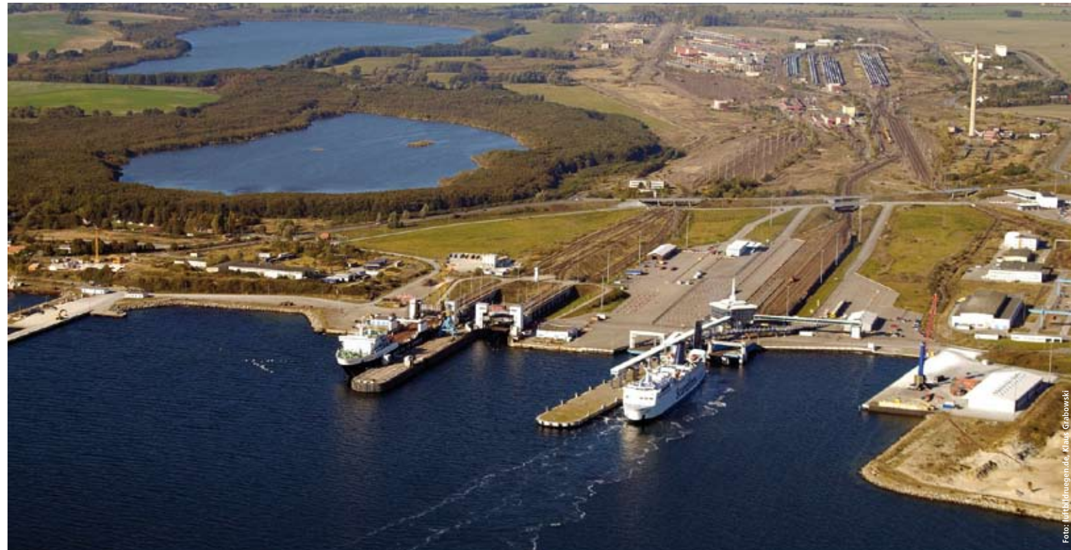
Der Fährhafen Sassnitz bietet neben den Eisenbahngleisen viel Platz für produzierende Unternehmen zur Ansiedlung
